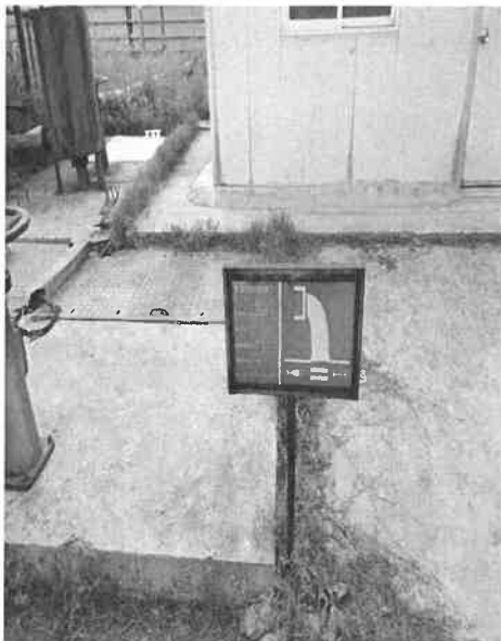
生活污水排放口
