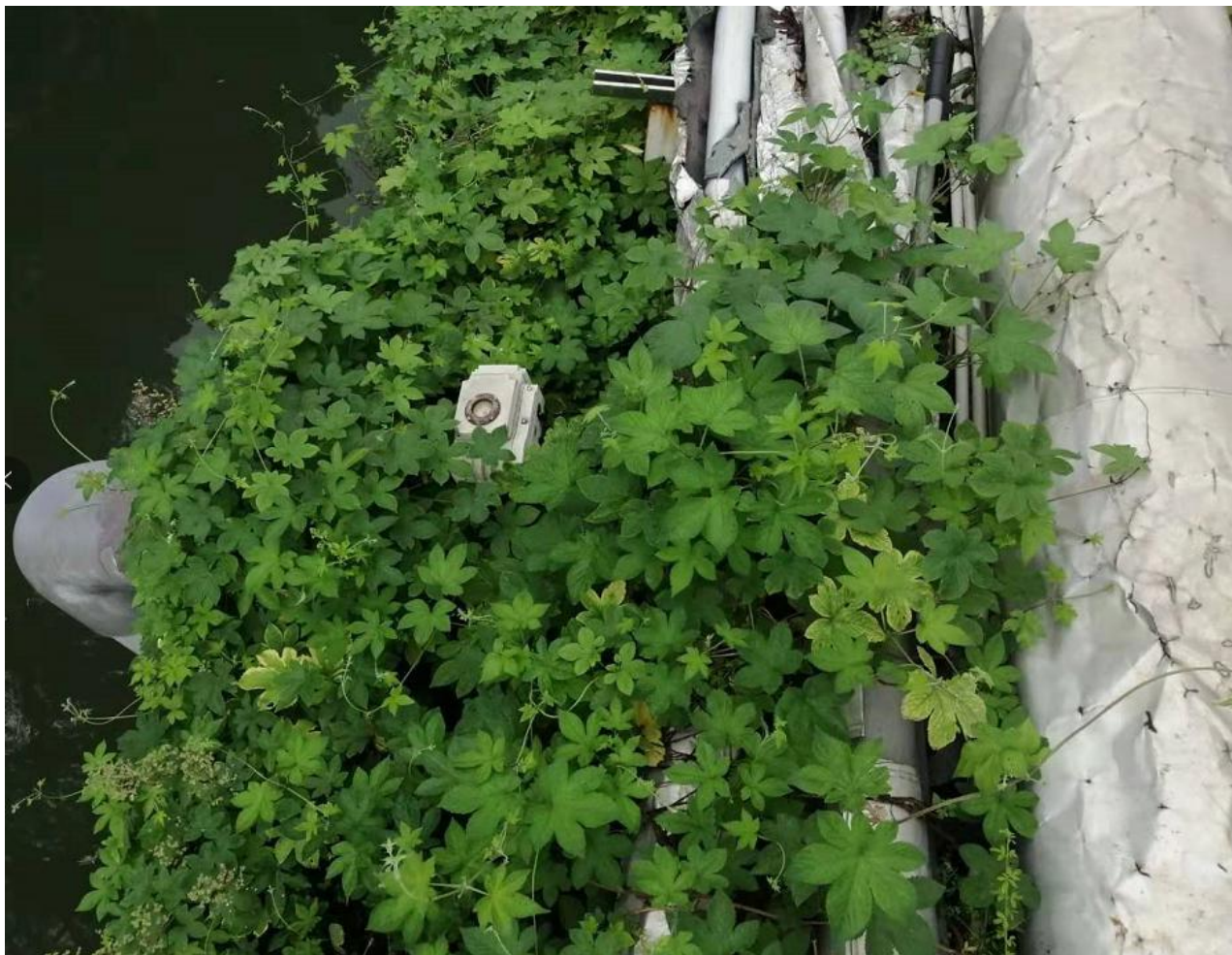
原有排放管路已关闭
