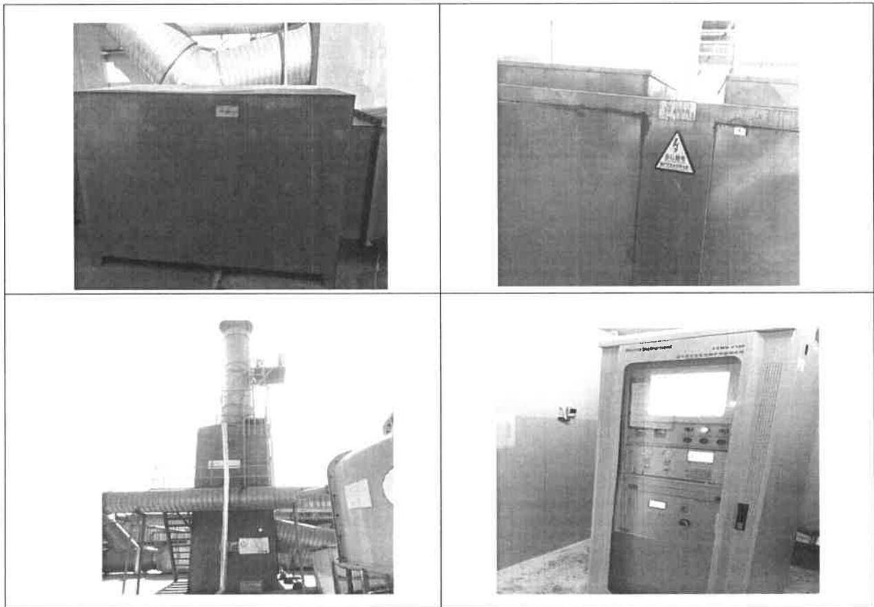
图 3-2 废气排口、处理设施及在线监控装置
