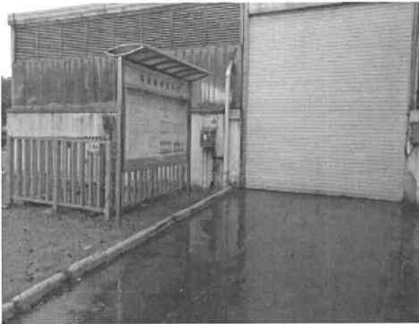
危废仓库（外部）
